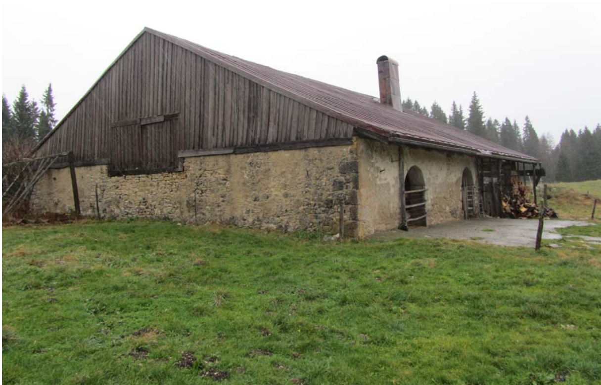
Le Pré-Loin, petit mais sympathique avec ses deux portes d'écurie voûtées.
